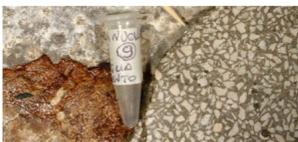
Fig. 5 e 6 Reintegrazioni eseguite con malte gessose con pozzolana o polvere di mattone
