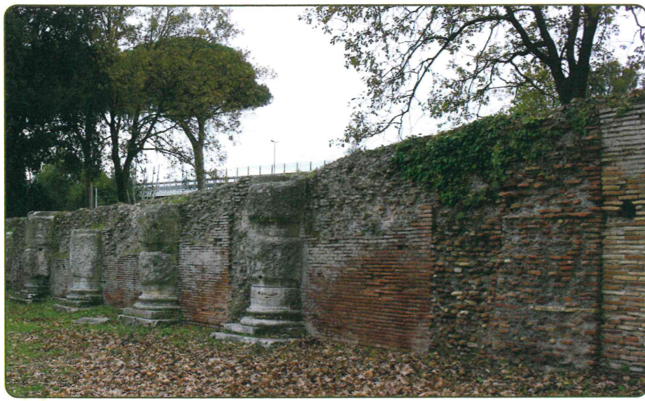
Veduta del Portico di Claudio inglobato nei magazzini
