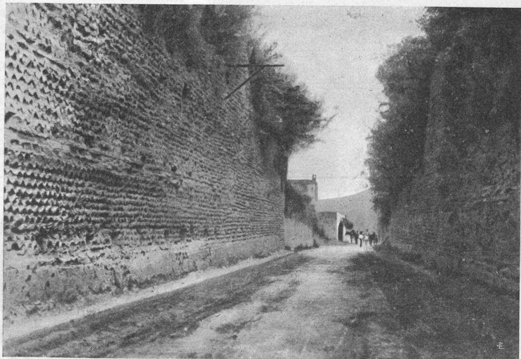
La « Montagna Spaccata », taglio romano sul fianco del cratere dal Piano di Quarto. I lati sono sostenuti dall'« opus reticulatum », che venne in uso verso la fine della Repubblica e si mantenne per quasi tutto il primo secolo dell'Impero, e dall'« opus latericium », che è caratteristico dell'epoca imperiale.
