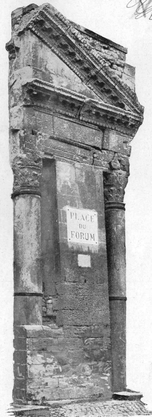
ARLES - COLONNE E FRONTONE DEL TEMPIO SUL FORO, IL CAMPIDOGGIO DELLA COLONIA.
