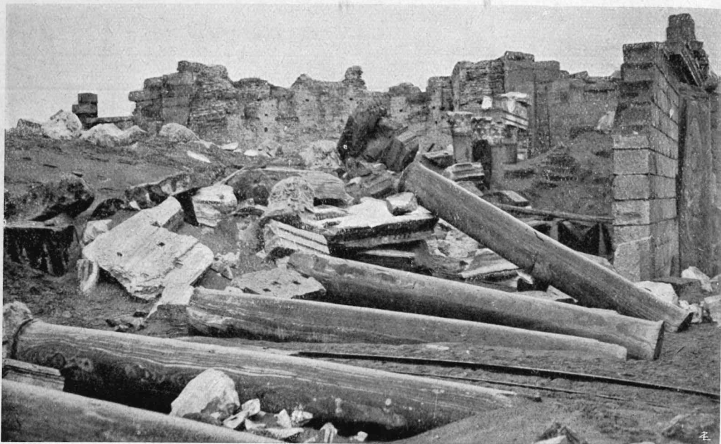
LEPTIS MAGNA. - COLONNE DI MARMO CIPOLLINO DELLA NAVATA LATTERALE DELLA BASILICA, ROVESCIATE SULLA SABBIA CON LA LORO TRABEAZIONE MARMOREA.
