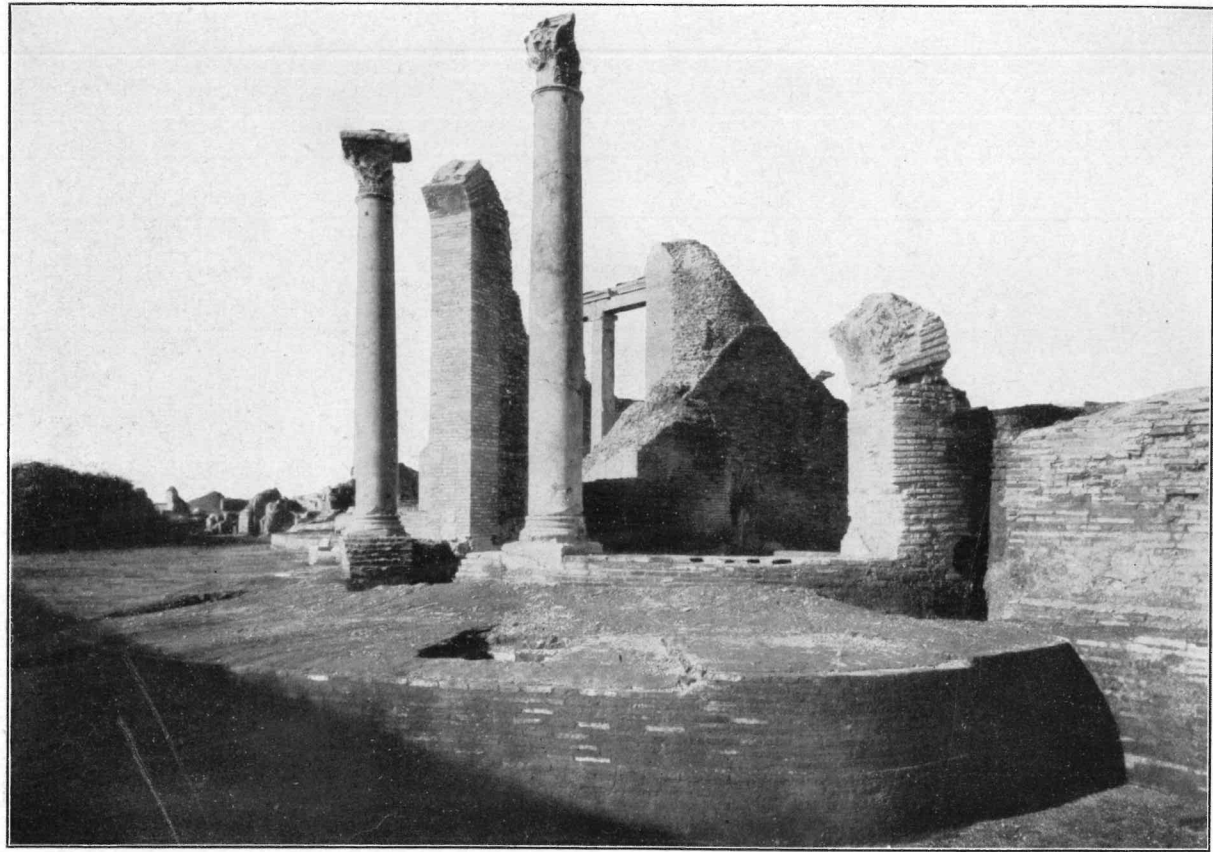
ABSIDE CONTENANT TROIS BASSINS POUR LES BAINS CHAUDS.
