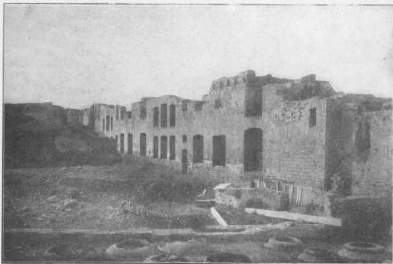
FIG. 1. — Prospetto del caseggiato nel cortile-giardino.
