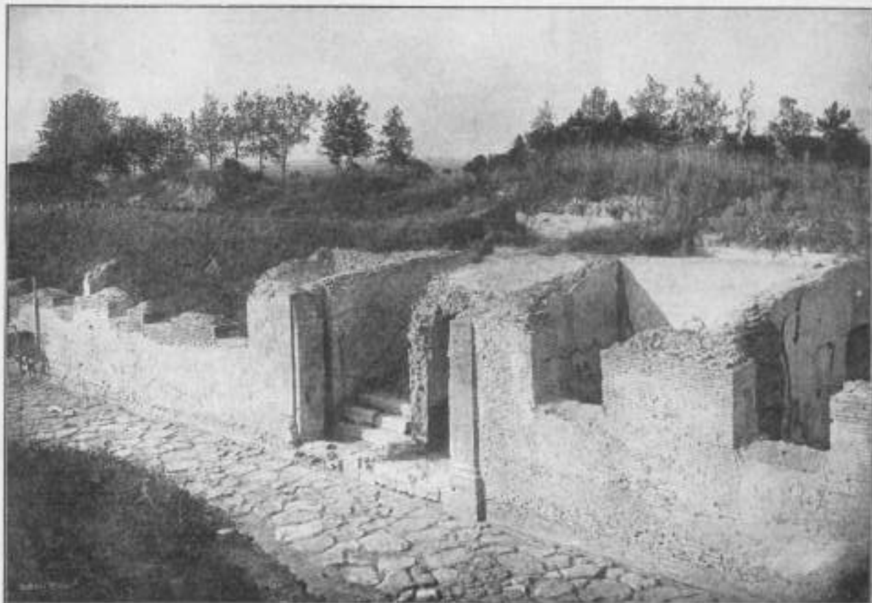
FIG. 15. — Casa in via de' Vigili — stato attuale.
