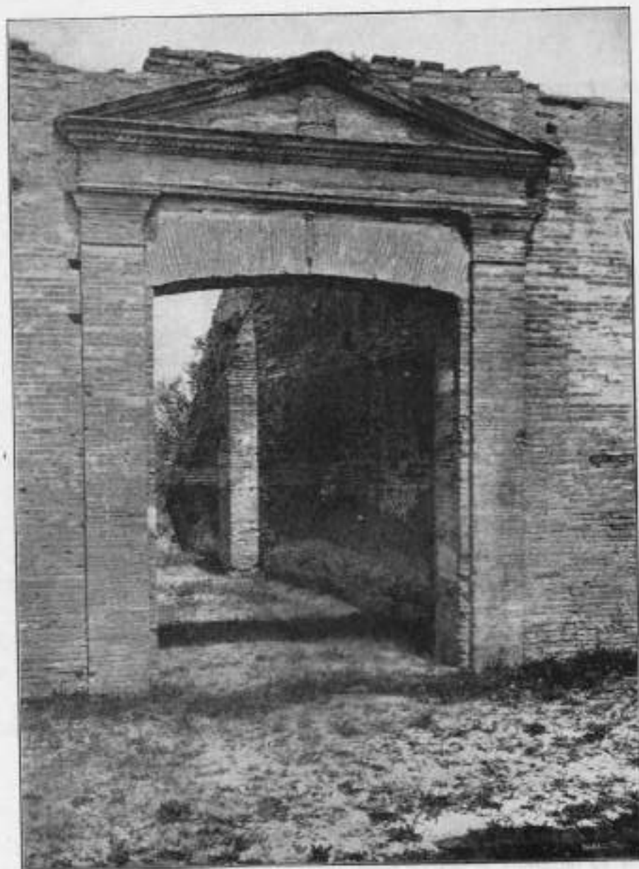
FIG. 6. — Decorazione usuale degli ingressi ai caseggiati — Ufficio dei misuratori del grano.
